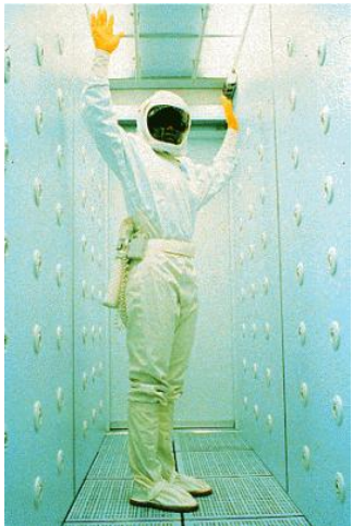
Dus de aer steril, la intrarea in clean-room din clasa ISO 6 ...
